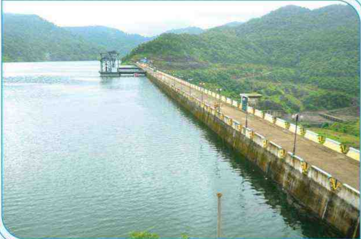
Middle Vaitarna Dam
