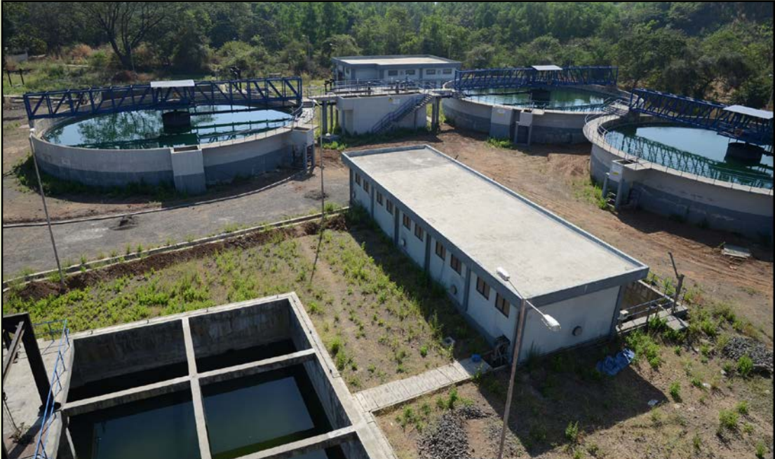
भांडुप कॉम्प्लेक्स येथील मेंब्रेन फिल्ट्रेशन प्लांट
